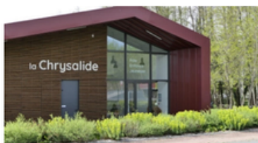
Accueil de loisirs sans hébergement intercommunal
