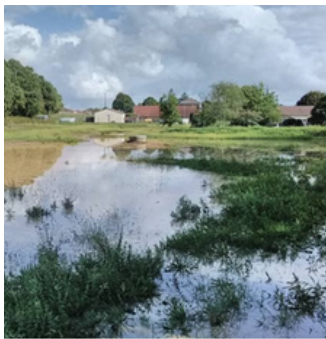
Zone humide aménagée collectant l'eau après une période de pluies
