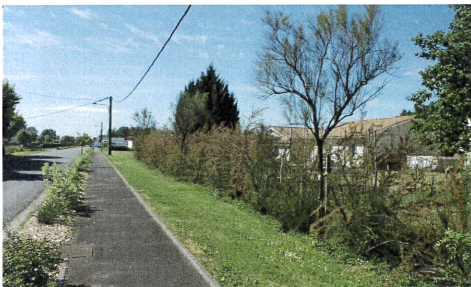
Voie piétonne et cyclable, séparée de la RD255, reliant le lotissement de logements sociaux situé à la pointe de la Borderie au bourg et ses équipements
