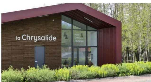
Accueil de loisirs sans hébergement intercommunal
