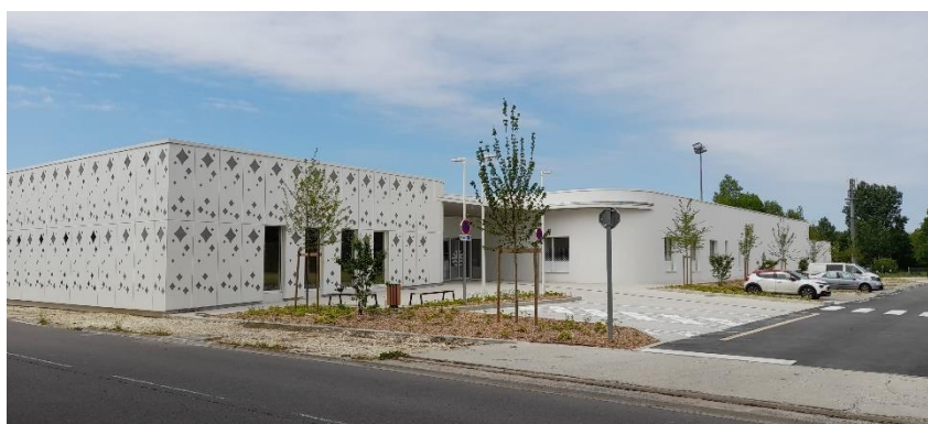
Piscine suite à son extension et sa réhabilitation
