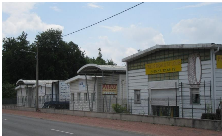
Bâtiments économiques de la zone d'activités de la Borderie le long de la RD255
