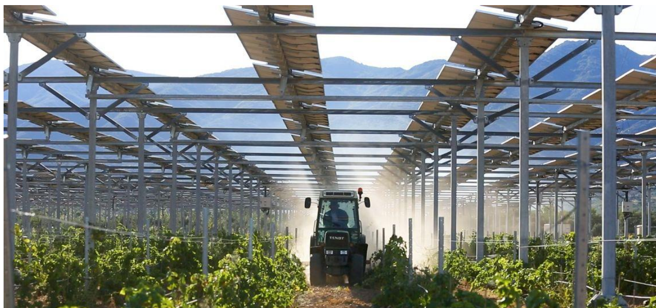
Exemple d'agrivoltaïsme, avec modules à inclinaison contrôlable
