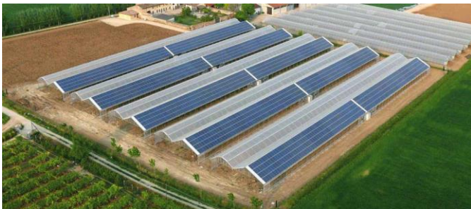
Contre-exemple de photovoltaïque sur serre
