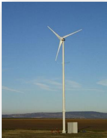
Eolienne à axe horizontal Eolys de 12 kW (source : SEPEN)
