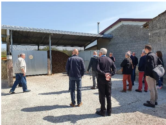
Visite du réseau de chaleur bois de la commune de Gênerac
