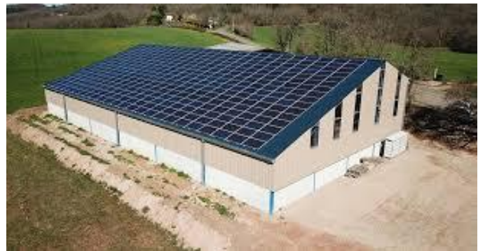
Solaire sur toiture agricole
