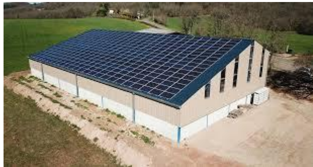
Solaire sur toiture agricole
