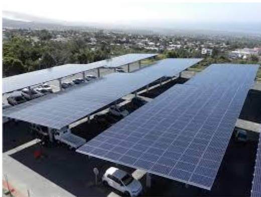
Ombrière sur parking
