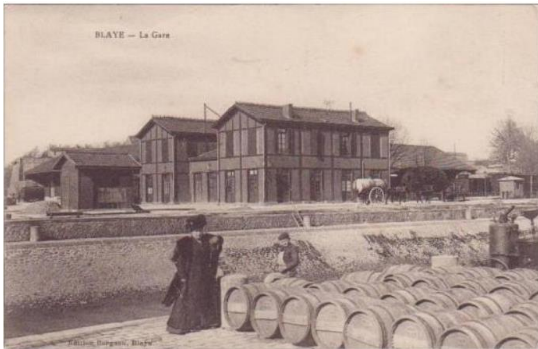
Figure 118 : Ancienne gare de Blaye et ligne vers Saint-Yzan (Cybercentre de Bourg, 2014)
