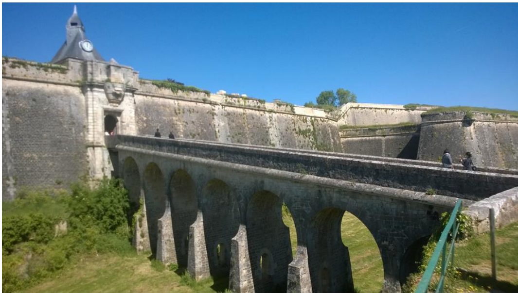
Figure 20 : La citadelle de Blaye (Photo Groupement RCT)
